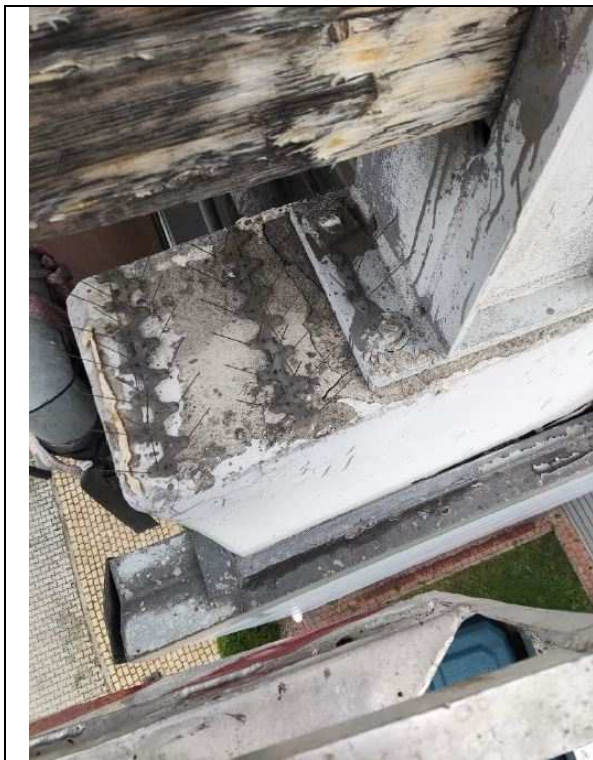
spękania oraz ubytki fragmentów betonu na głowicach słupów
