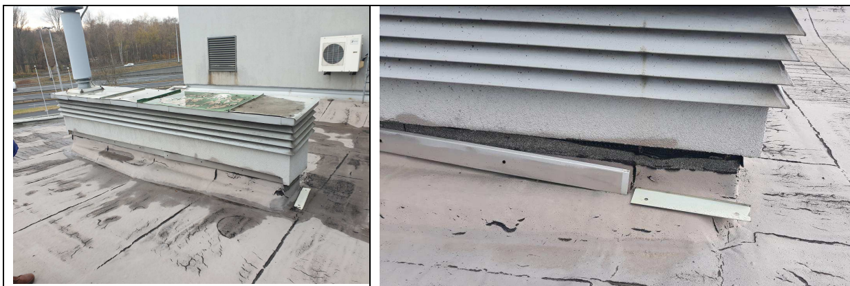
nieszczelne i odspojone listwy dociskowe na ścianach (styk ściana-dach), kominach
