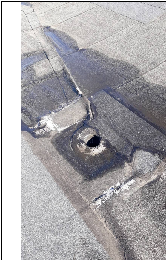
nieprawidłowe ukształtowanie spadków dachu do wpustu, co powoduje zaleganie wód opadowych w najniższych miejscach krzywizny dachu, brak koszy ochronnych
